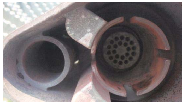
รูปภาพแสดงชุด Pilot Tip ของ Flare Stack V-9801
